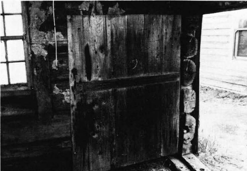
Les portes sont en planches verticales variant entre 9" et 14" de largeur. Ces planches verticales sont reliées entre elles par une ou plusieurs planches horizontales.
