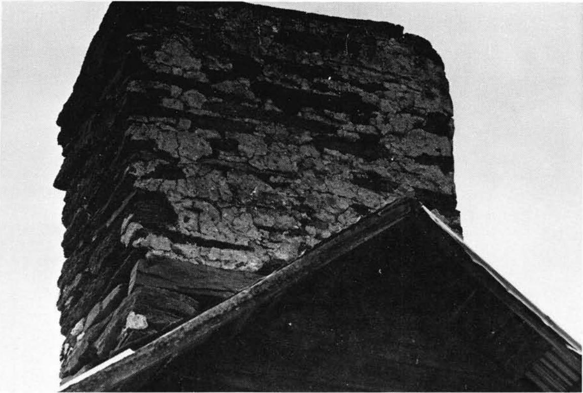
On ne retrouve qu'une seule cheminée qui est faite de pierres recouvertes de crépit. Elle dépasse la couverture de 3' et mesure 2' 4'' x 4' 6'' au haut.
