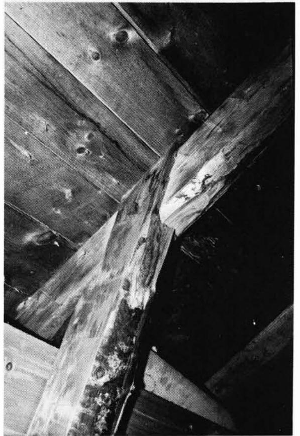
Au grenier, les poutres sont attachées avec des chevilles. Les poutres ont été taillées de façon à s'ajuster une dans l'autre.
