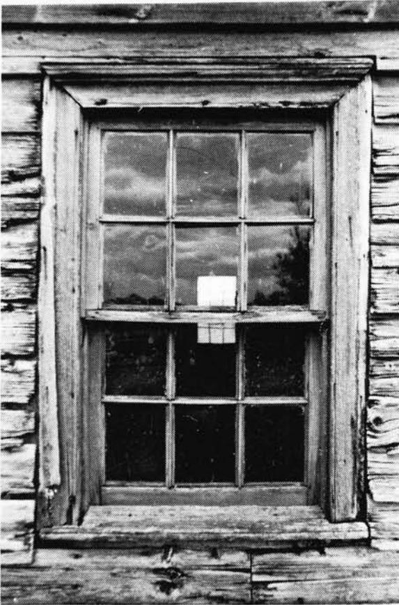
Ce sont des fenêtres à carreaux, 12 carreaux chacune. La grandeur des fenêtres est de 3'4 1/2" x 2'.
